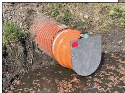
Die Hochwasserschutzanlagen, hier eine Rückstauklappe, werden von unseren Mitarbeitern immer wieder genau kontrolliert und wenn nötig gereinigt!
